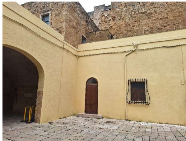
Figura 30 – Ingresso fronte Sud, accesso principale da ponte con arco
