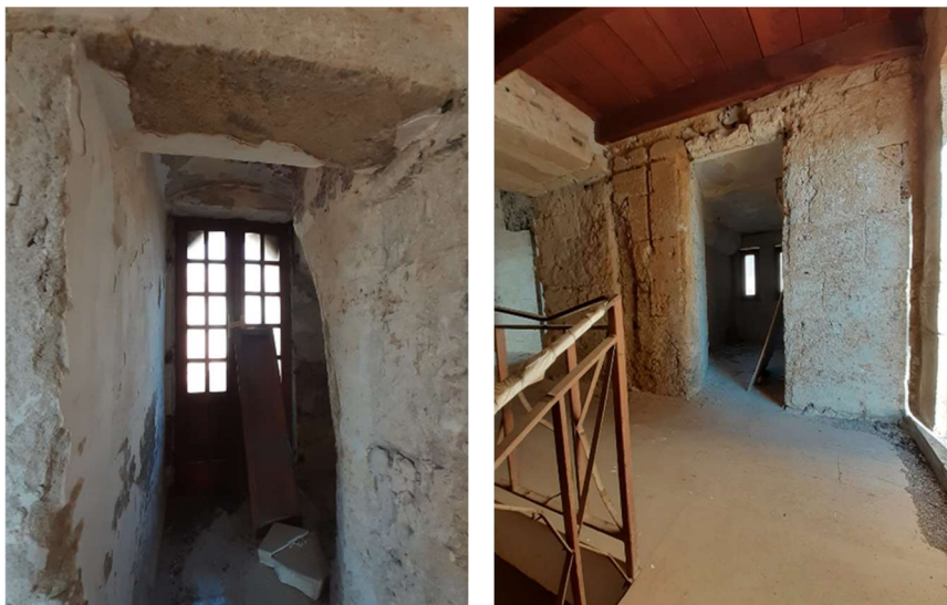
Figura 27 – Dettaglio del vano negli spessori murari e deterioramento dello stesso
