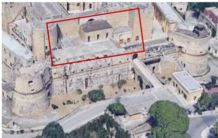
Figura 4: Vista a volo d'uccello post 2009: rimozione delle volumetrie e delle guaine di copertura
