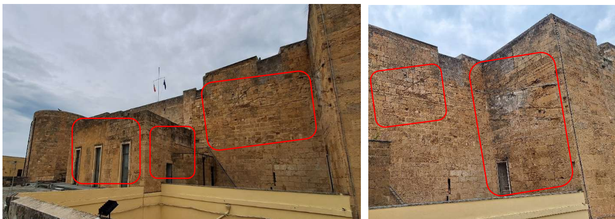
Figura 34 - Prospetto esterno interessato da lavori di risarcitura di piccole lesioni lato Sud- Est
