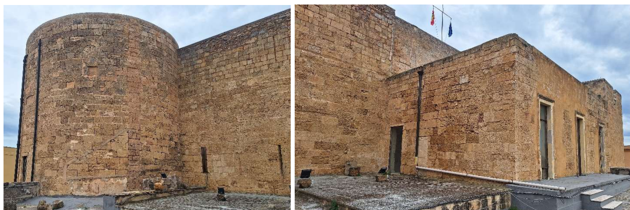
Figura 22 - Terrazzo esterno lato Sud-Ovest
