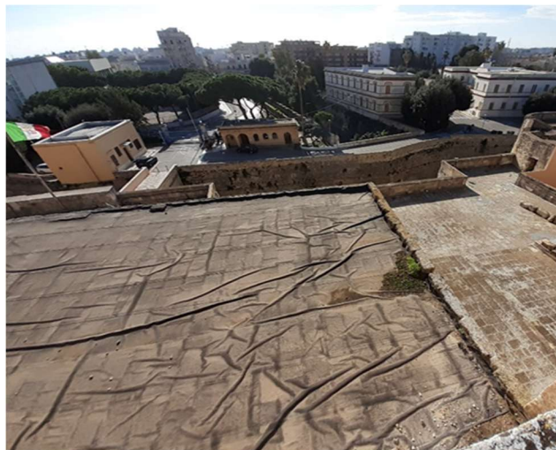
Figura 26 - Strati di guaina ormai vetusti in copertura
