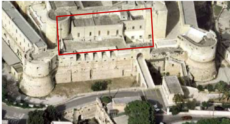
Figura 3: Vista a volo d'uccello ante 2009: presenza di superfetazioni e guaine impermeabilizzanti
