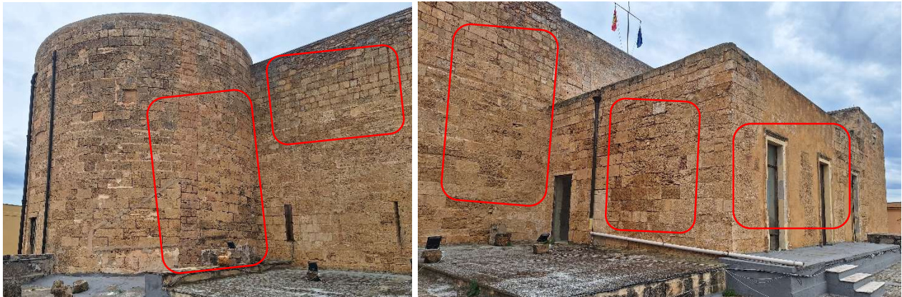
Figura 35 - Prospetto esterno interessato da lavori di risarcitura di piccole lesioni lato Sud-Ovest
