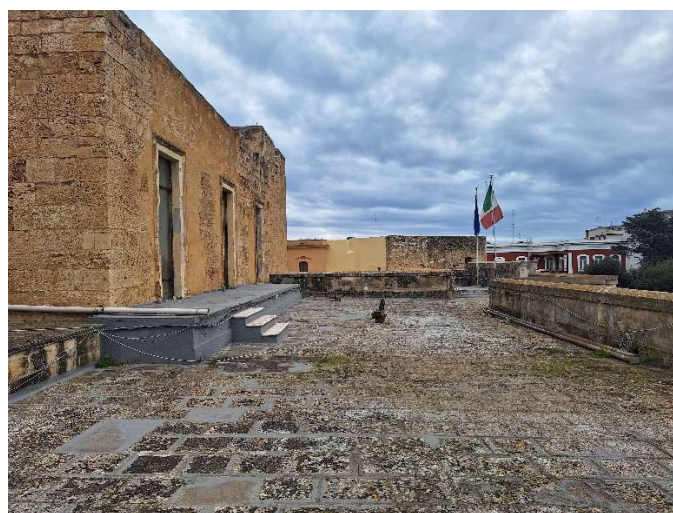
Figura 25 - Terrazzo esterno lato Sud
